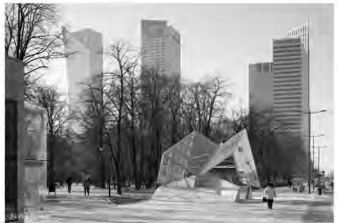
Centralny odcinek II linii metra, stacja C11, Warszawa, 2011–2015
