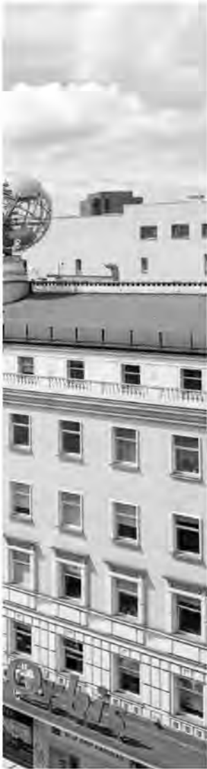
Przebudowa i rozbudowa DT Smyk (dawniej CDT), Warszawa, 2018
