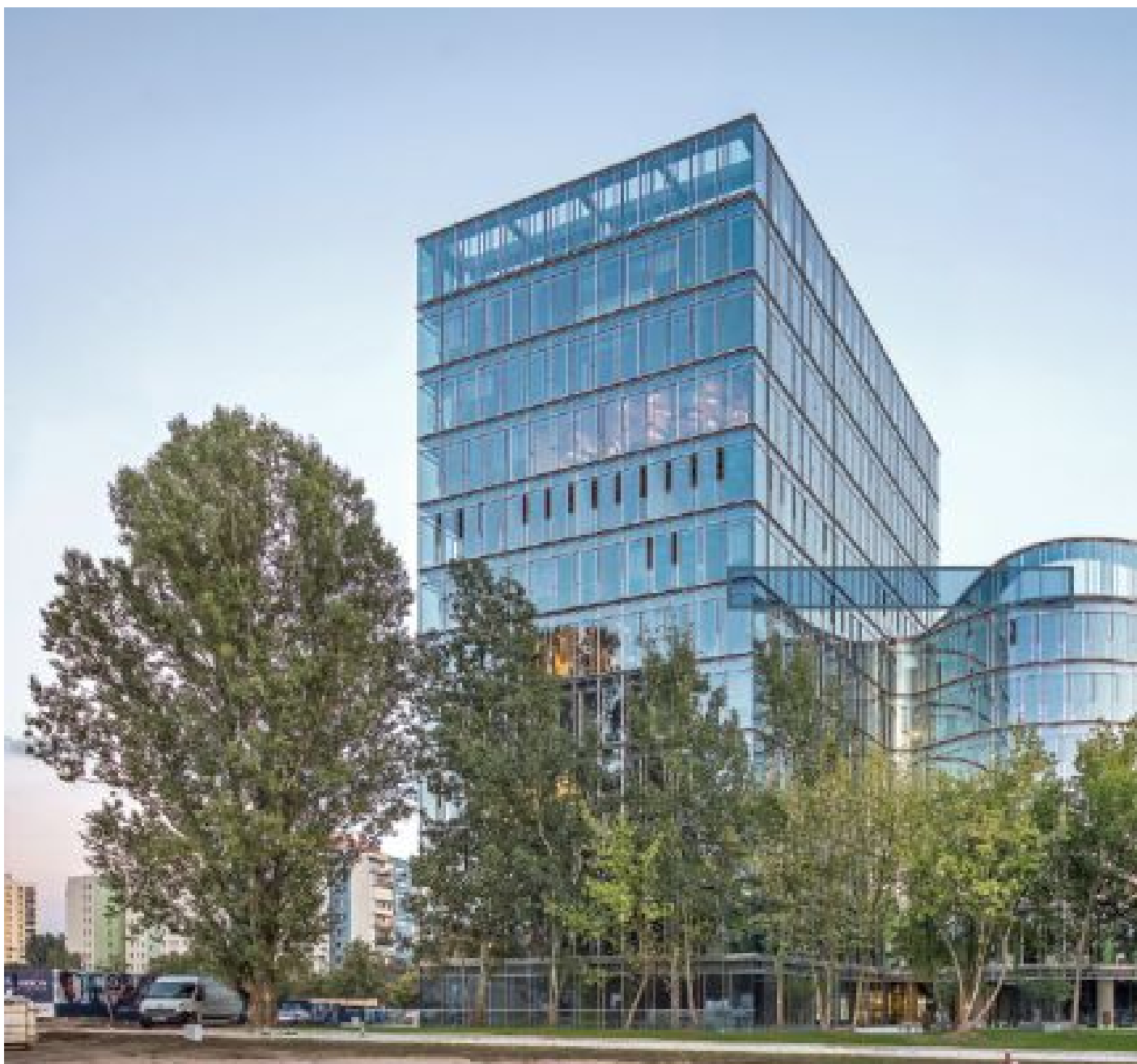
Północna elewacja biurowca Kronos Ambassador.
